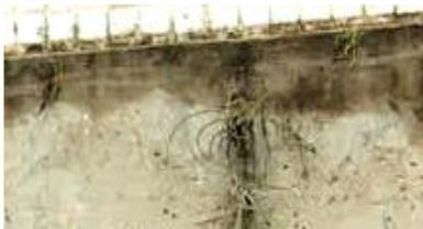
**Crecimiento vegetal.** Presencia de plantas en los elementos, generalmente encontradas en los bordes o superficies superiores, debido al depósito de humedad y semillas colocadas por aves.
