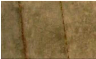
**Corrosión del acero de refuerzo.** Se observan manchas de oxidación del acero de refuerzo en la superficie del miembro. En ocasiones se puede contemplar la barra de refuerzo expuesta en la superficie.
