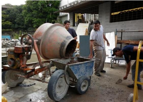
Fotografía 3.11: Vaciado de la mezcla en el buggie
