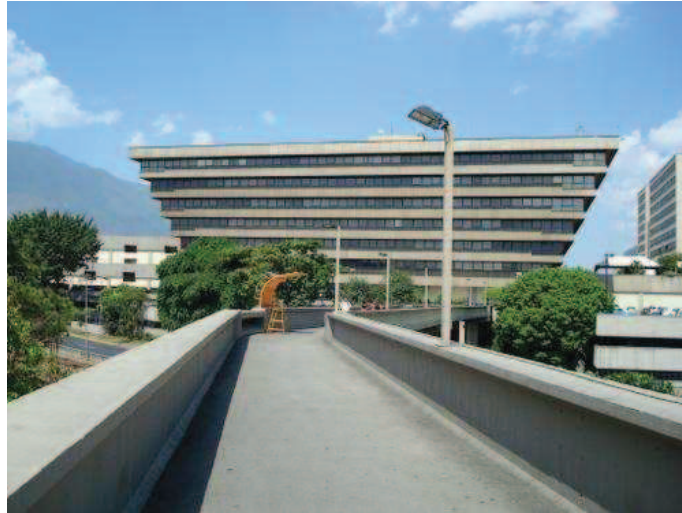
Edificación con aumento de masas con la altura. (CCCT)
