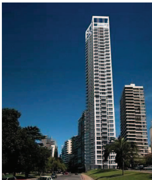
. Edificación con esbeltez excesiva
