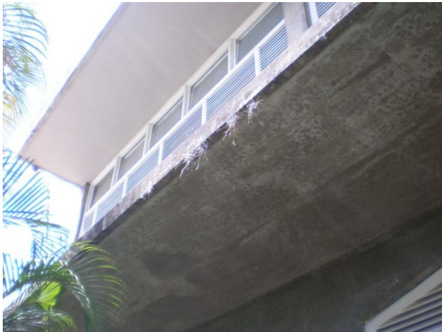
B.6.2. Capa vegetal en losa de techo (Módulo 6-Nivel 1)
