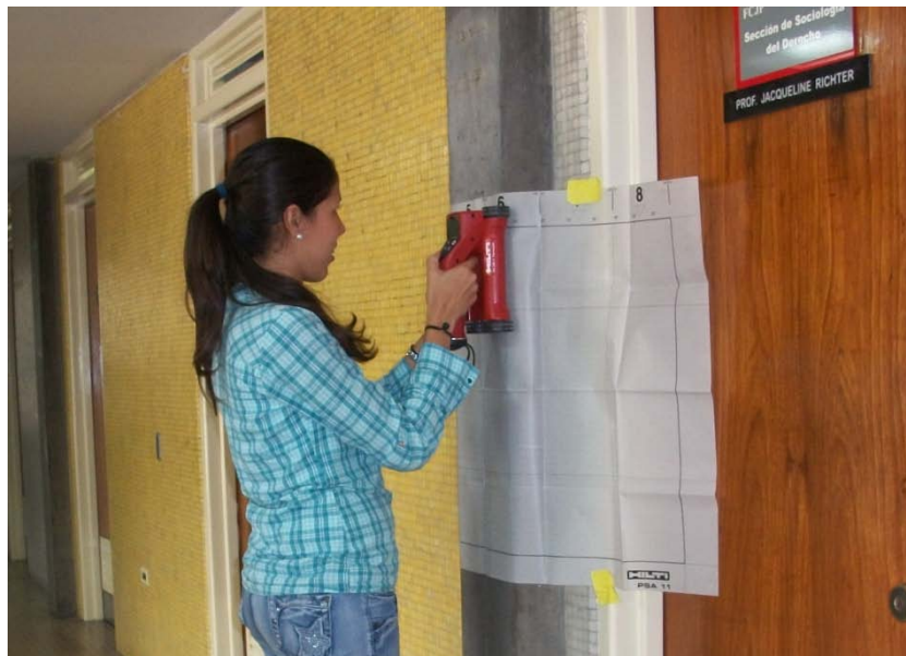
Figura 39. Ensayo no destructivo en columna
