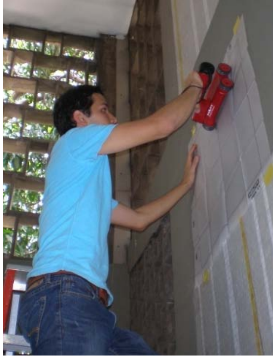
Figura 40. Ensayo no destructivo en viga
