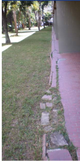
B.6.1. Capa vegetal en caminaria del jardín (Módulo 2 y 3- Planta baja)
