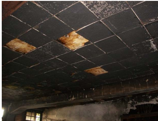
B.7.1. Efecto del fuego en el recubrimiento de techo (Módulo 5-Planta Baja)
