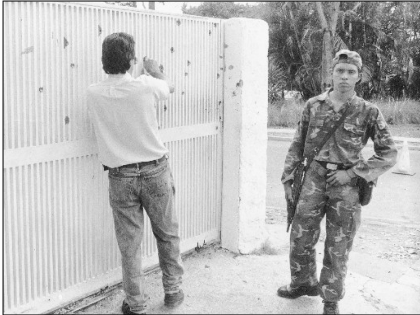
Fotografía N° 26 José Grillo. Vecino de La Casona enseñando los destrozos de la reja de su casa a un militar.
